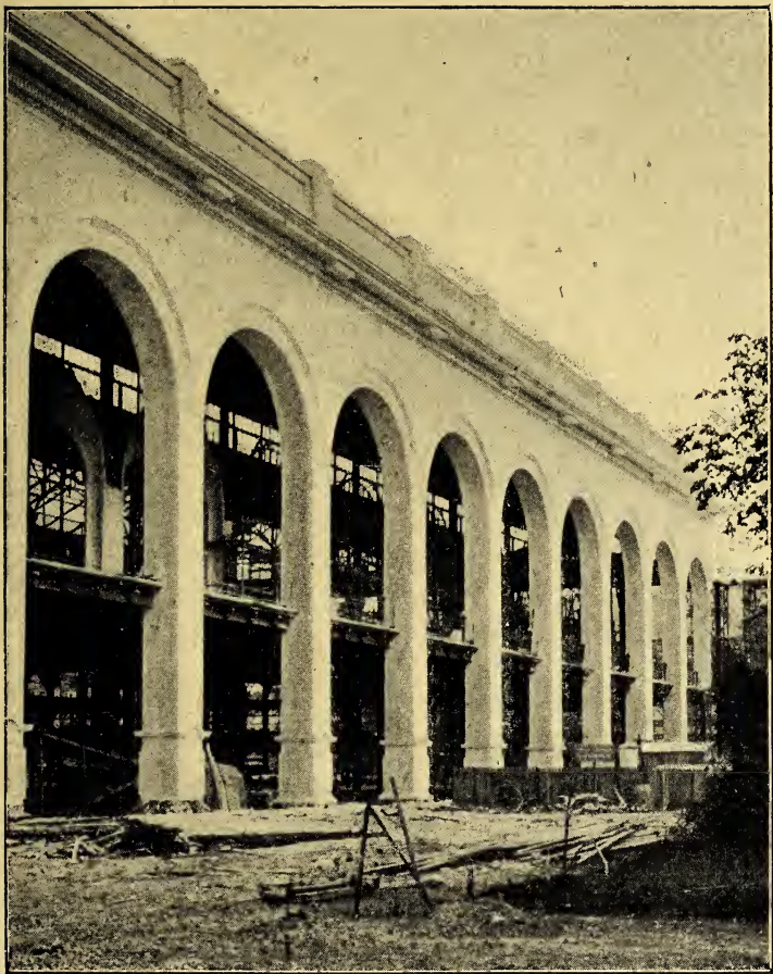
CHAMP-DE-MARS. — PALAIS DES INDUSTRIES DU FIL (12 juin 1899). M. BLAVETTE, architecte.
